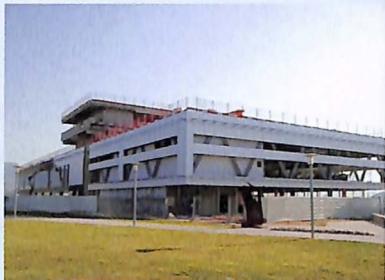
Le casino JOA en construction
