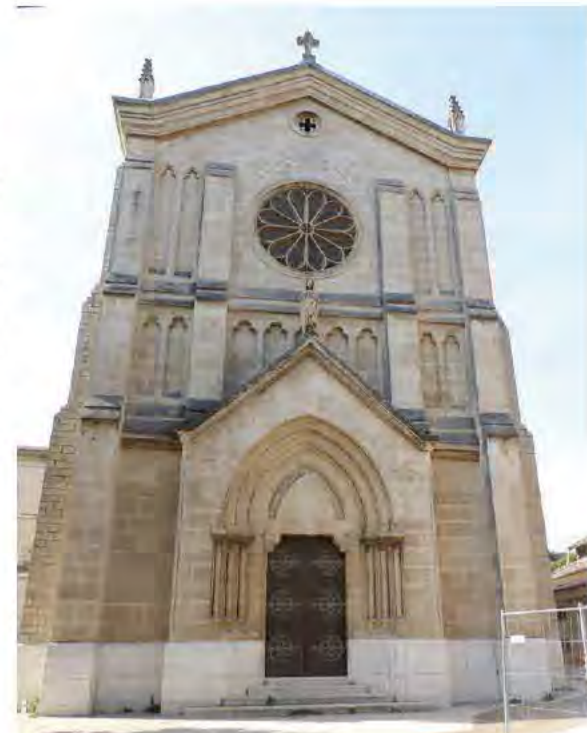
Façade dégagée de la chapelle des Maristes
