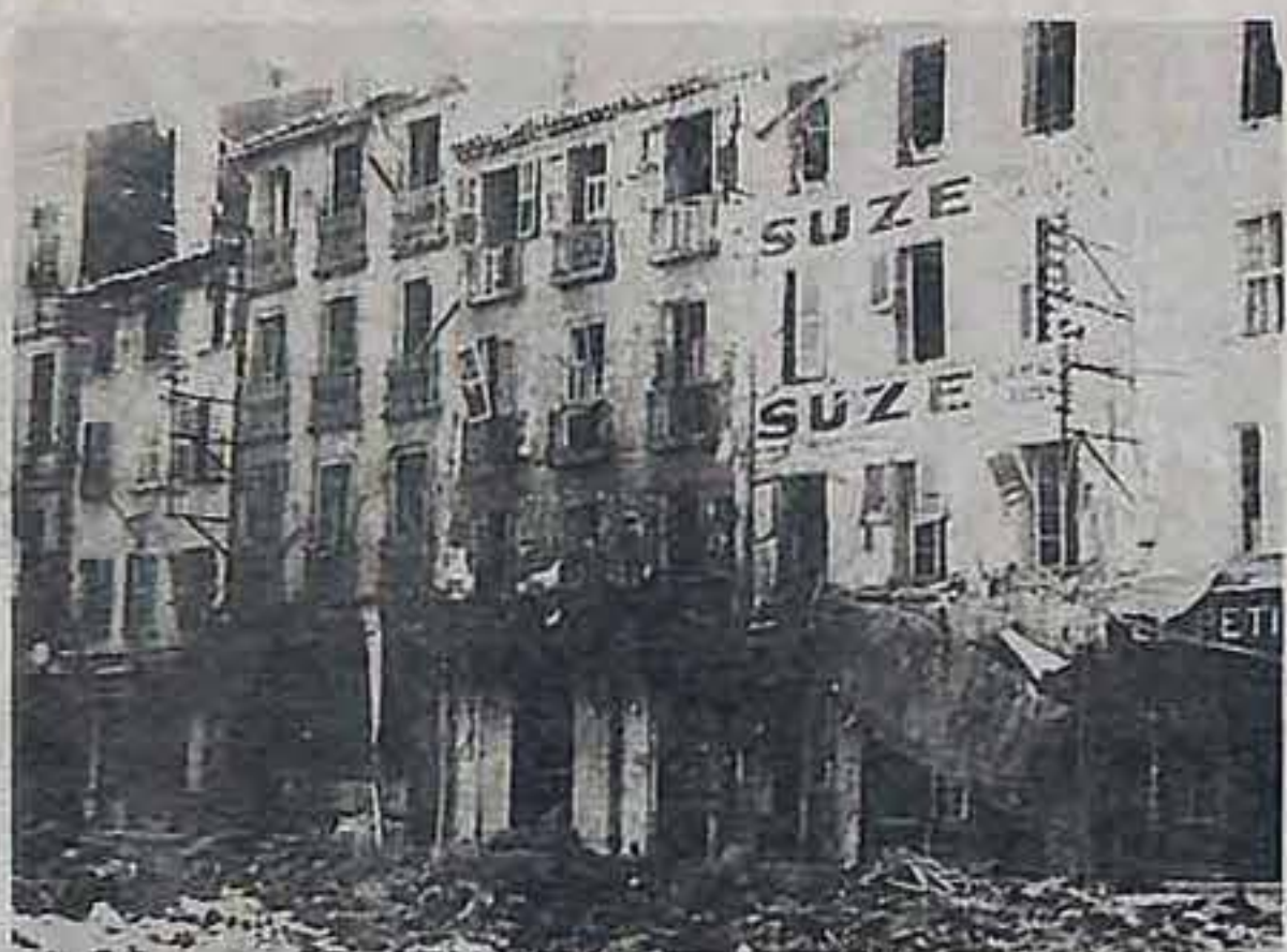
Les quais du port qui avaient été minés par les Allemands en août 1944 restent à reconstruire.
