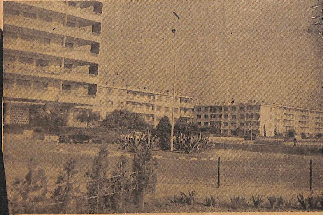
MAR-VIVO : La Municipalité a fait un effort croissant pour satisfaire les besoins de la population de ce quartier en pleine expansion. (Photo Petit Varois).
