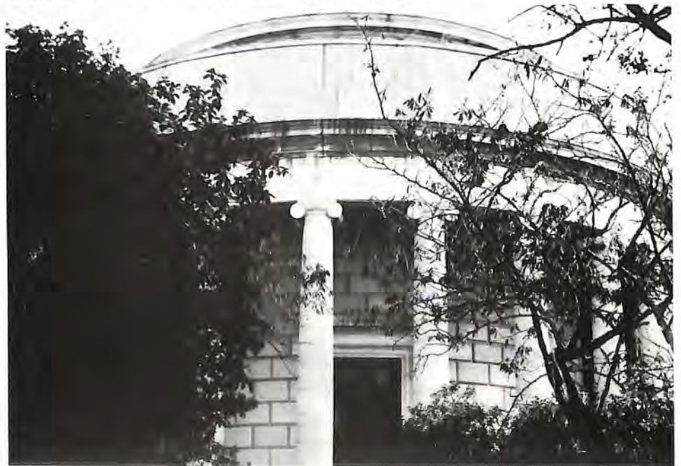
D'un diamètre de 16,50 m, la coupole de la chapelle des mécaniciens s'appuie sur 24 colonnes à tambour d'ordre ionique.
