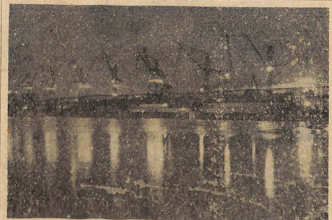
La centrale hydroélectrique de Kouibychev fournira bientôt du courant aux régions avoisinantes. Les travaux se poursuivent pratiquement sans interruption. Sur notre photo, une vue nocturne (partielle) des installations.
