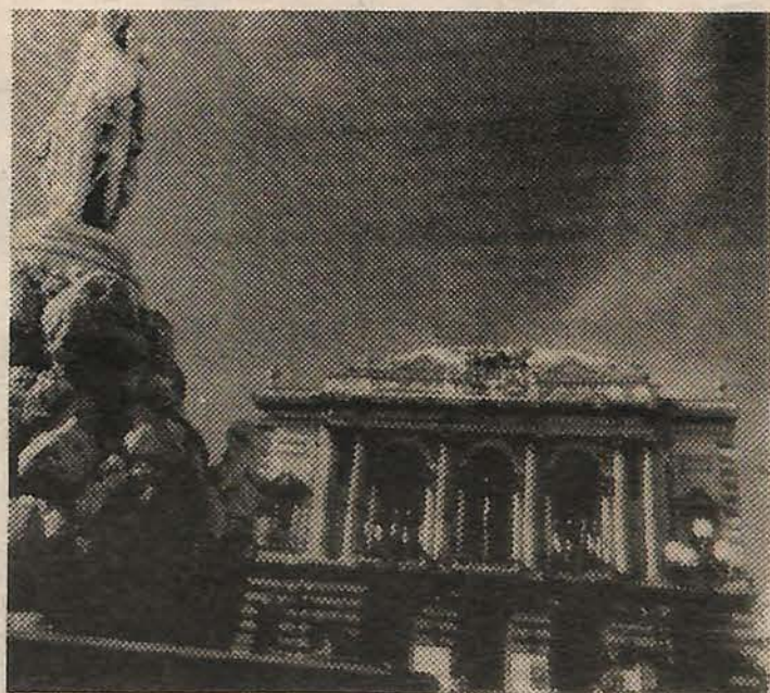
Travaux d'aménagement de la Place de la Comédie à Montpellier
