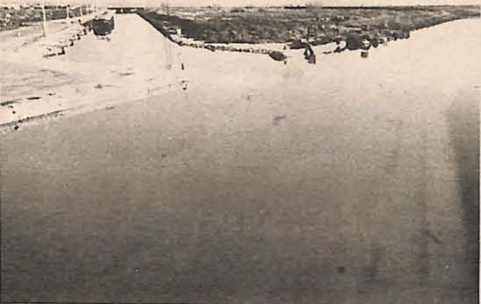
Canal du Rhône à Sète Travaux d'aménagement
