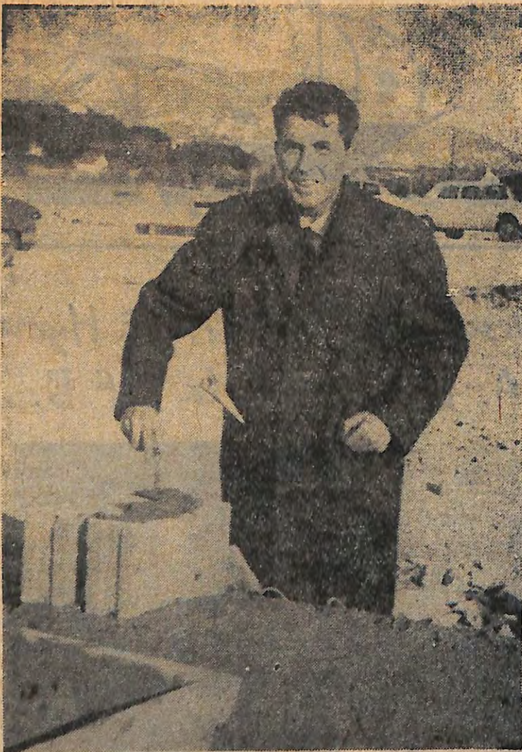
Le 1er FEVRIER 1964, M. Merle, maire de La Seyne pose la 1re pierre du groupe « Floreal » 556 logements.
