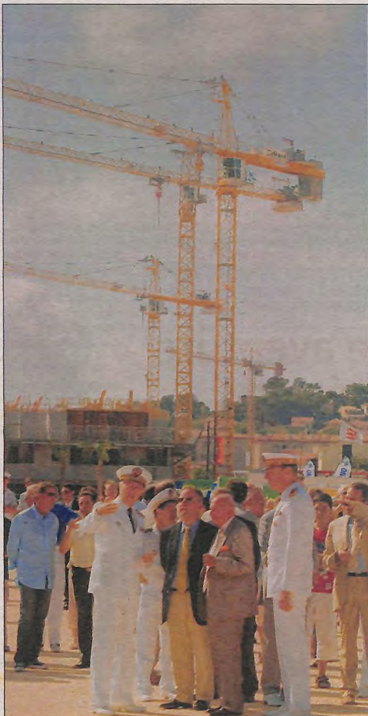
Des chantiers navals aux grands chantiers (ci-dessus, lors de l'inauguration de « l'esplanade marine »)... Le nouvel avenir dessiné pour La Seyne par son maire Arthur Paecht est aujourd'hui au cœur de la campagne électorale. (Photo doc. D. Leriche)
