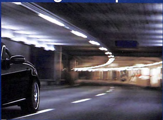
Passage sous Dalle
