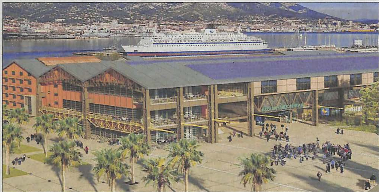
Vue du projet de reconversion du hangar CPM qui doit accueillir un complexe cinéma, un hôtel, des restaurants, etc. (Photo doc. DR/ AOA Architecte))
