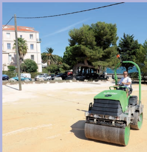
L'intégralité des travaux du parking a été réalisée en régie
