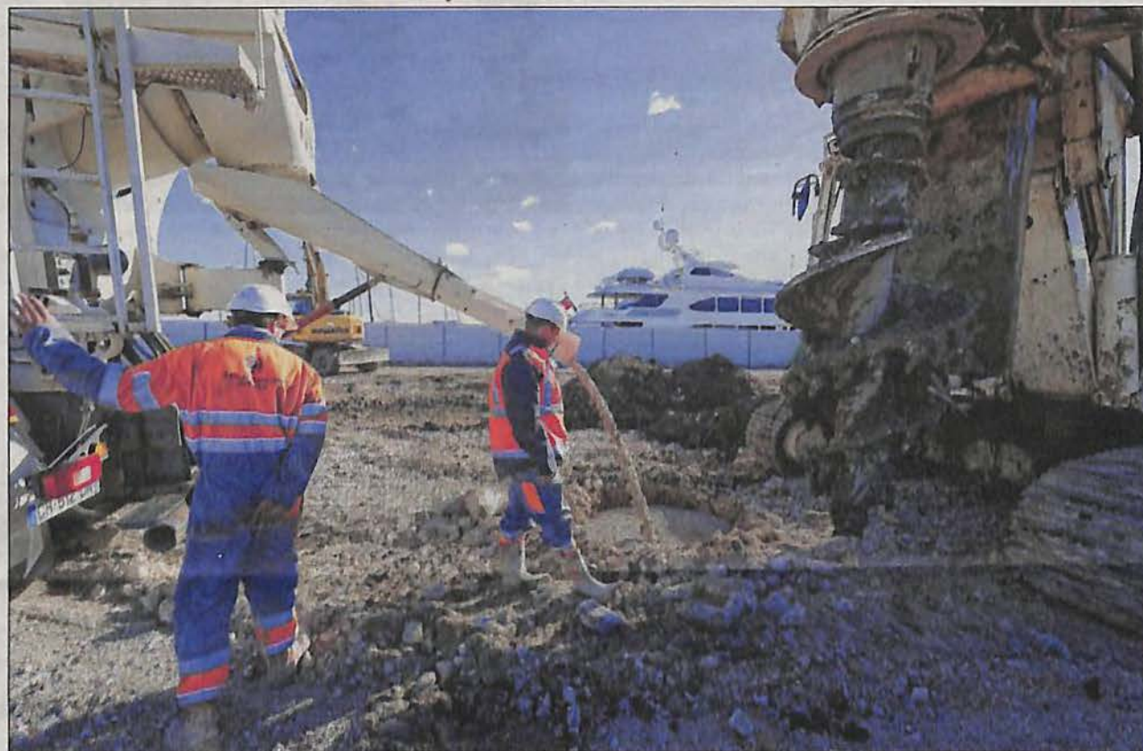
Lancé en octobre dernier sur le site de la navale, le chantier du grand casino a été interrompu début février. « Les travaux vont reprendre en septembre » a déclaré le directeur Dylan Peyras. (Photo doc Dominique Leriche)
