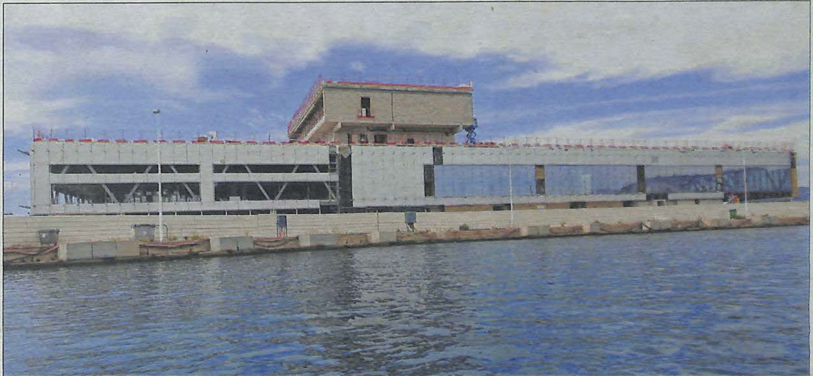
Les différents volumes du bâtiment sont désormais bien visibles. Sur la partie droite, le parking, l'accueil et la salle des spectacles. A gauche, la salle de jeux et des locaux techniques. Au sommet, les deux restaurants. Prochaine étape majeur du chantier : la mise hors d'eau et hors d'air, prévue mi-septembre. (Photos M. G. et DR)
