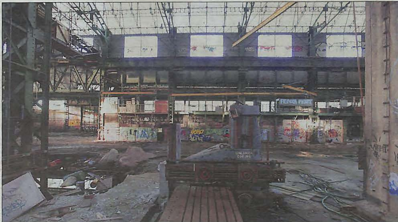
À l'intérieur, l'espace est immense : plus de 25 000 m 2 aménageables. Au milieu des débris et détritus, quelques machines rappellent le passé industriel des ateliers mécaniques. (Photos Eric Estrade)
