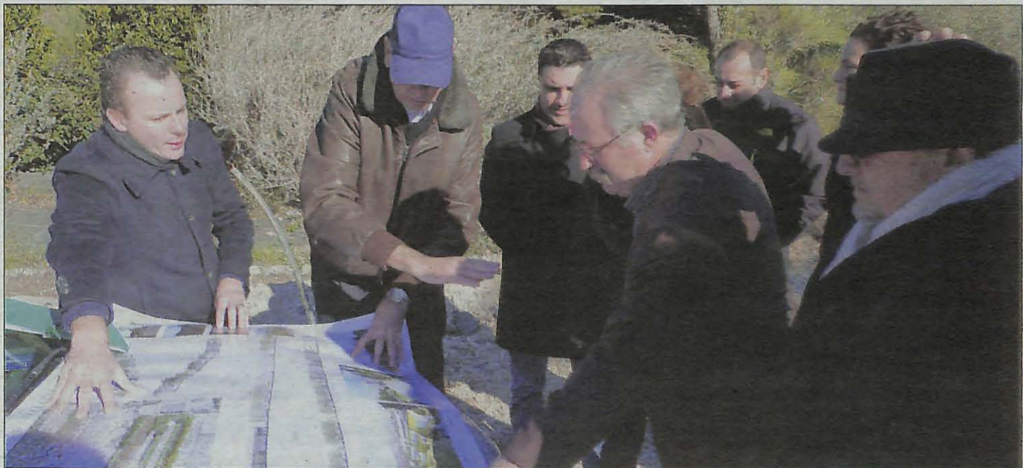
Marc Vuillemot est venu se rendre compte sur place, du lancement du chantier, en compagnie des représentants du groupement d'entreprises chargé de l'opération.
