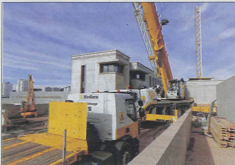
Le gros œuvre de la structure est terminé. Il faut maintenant réaliser l'électricité, les sols et les plafonds.
