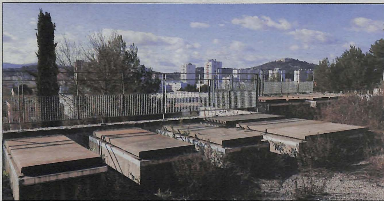
Les allées du cimetière de Camp Laurent sont désormais envahies par les herbes. (Photos Dominique Leriche)
