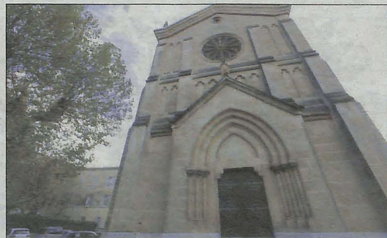
La façade de la chapelle ouverte à la vue de tous, un vœu pieu ?
