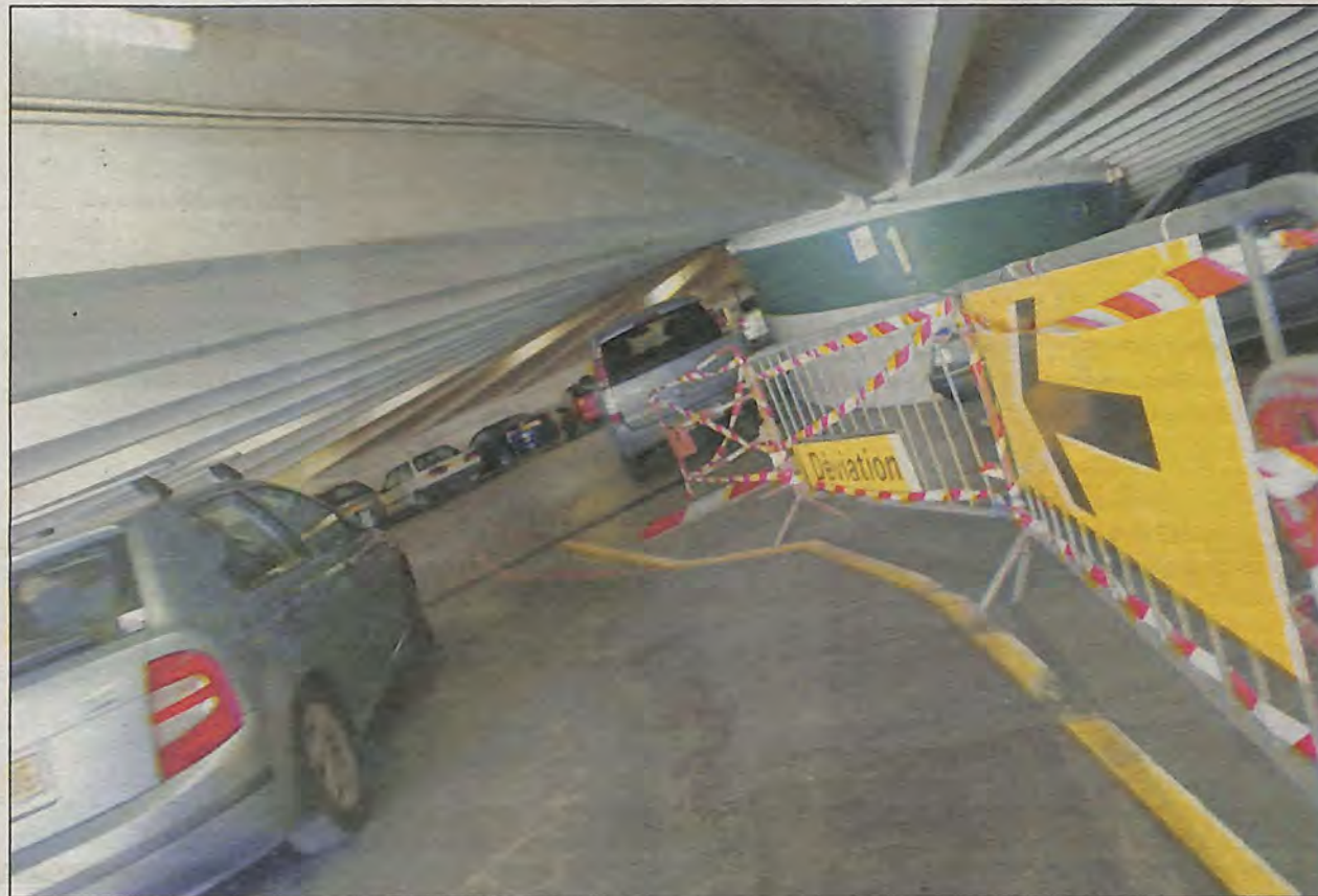
Les travaux ont déjà débuté à Martini. La société Omniparc, à qui la ville a délégué l'ensemble du stationnement en juillet 2007, s'est aussi engagée à construire, à ses frais, un parking à étages aux Esplageolles.
