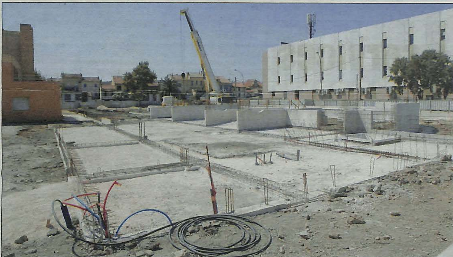
Le chantier devait encore durer un an, mais Q-Park a demandé aux entreprises exécutantes de vider les lieux. Aucune justification officielle n'est parvenue en mairie. Le contrat avec la Ville en est-il caduc pour autant? (Photo Éric Estrade)
