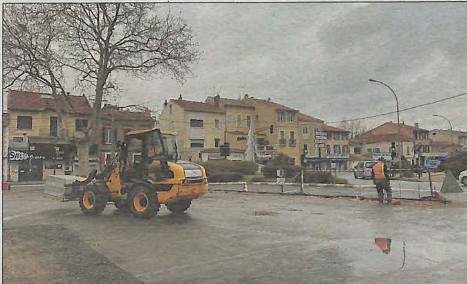
Depuis le 14 janvier dernier, les engins déblaient le terrain.
