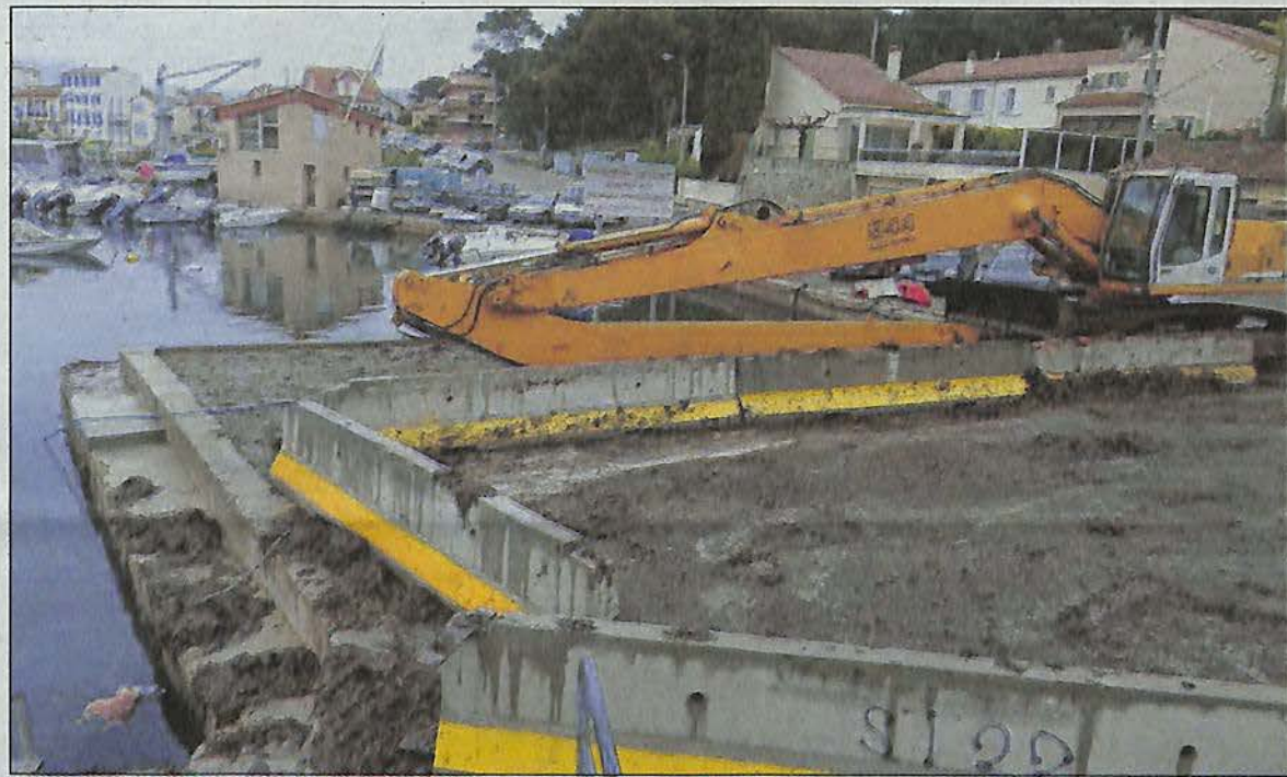
Le courant généré par les pompes n'ayant pas réussi à décoller la masse des posidonies accumulée au fond du bassin, l'autorité portuaire revient au traditionnel nettoyage à la pelleuse. (Photo C.G.)
