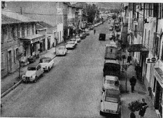
Elargissement de l'avenue Gambetta
