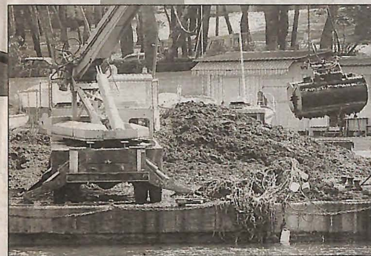
Les travaux de dragage du port de Saint Elme ont fortement mécontenté les riverains qui ont dû supporter les mauvaises odeurs.
