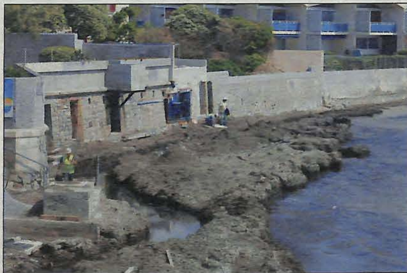
L'Estanco, situé au bout de la plage, n'a pas encore pu ouvrir en raison des travaux sur les conduites d'assainissement.
