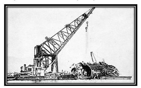
marins désaffectés également employés pour le décollage du fond. On fixe des flotteurs à des chaînes passant sous la coque grâce au travail des scaphandriers. Mais ce n'est que le 25 février 1925, que la dernière partie de l'épave (l'arrière) est soulevée et déplacée dans une forme de radoub des bassins Vauban. Il s'est écoulé une longue période de 13 ans et 5 mois depuis l'explosion. La grande grue des Forges et Chantiers
